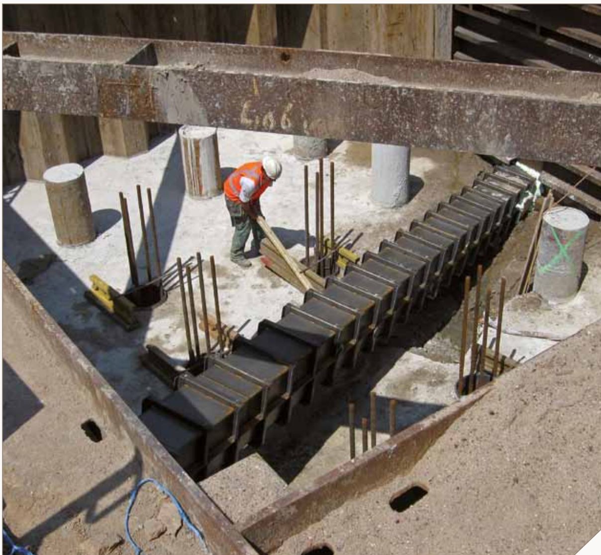
Fig. 2 Ingepakte kabels of leidingen die niet omgelegd konden worden.
